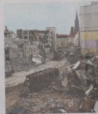
Derzeit laufen in Ulm die Abbrucharbeiten für das Center „Sedelhöfe“. Foto: Bäßler
